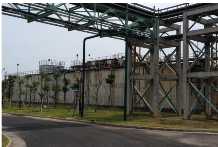
图4.1-4 酚氰废水处理站
