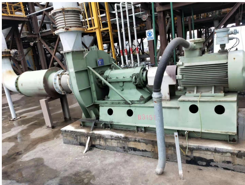
图 4.1—15 噪声防治措施（减振基础）
